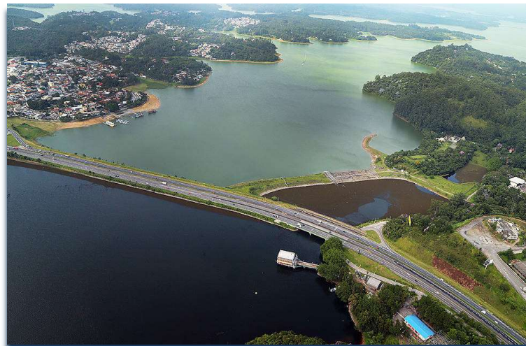
Foto 6 - Corpo Central II, vista do Bairro Riacho Grande
