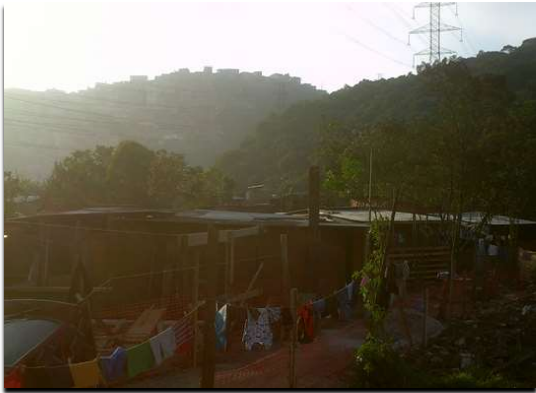
Foto 17 - Precárias ocupações no Corpo Central II
