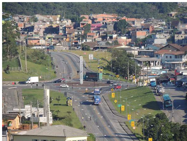
Foto 11 - Rodovia SP 122 - Rio Grande da Serra
