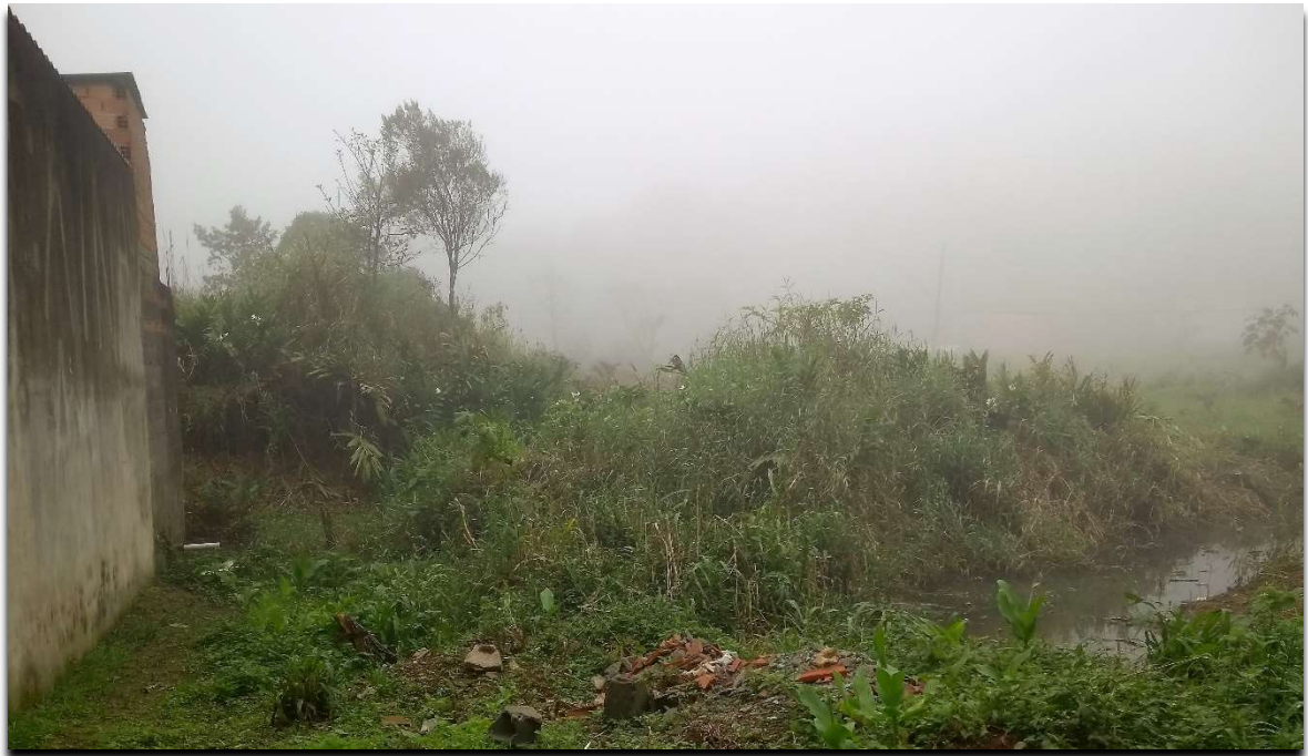
Foto 23 - Lançamento de esgoto em corpo d'água em RGS
