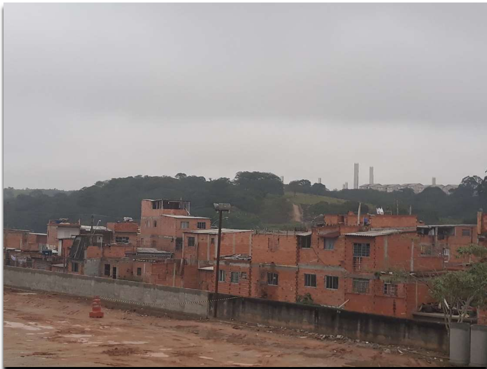
Foto 26 - Ocupações clandestinas sobre APP - Jd. Pedreira
