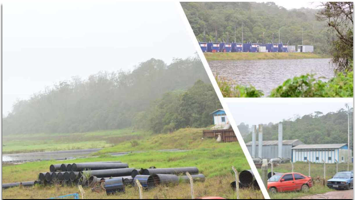
Foto 16 - Sistema de transposição Rio Grande - Alto Tietê
