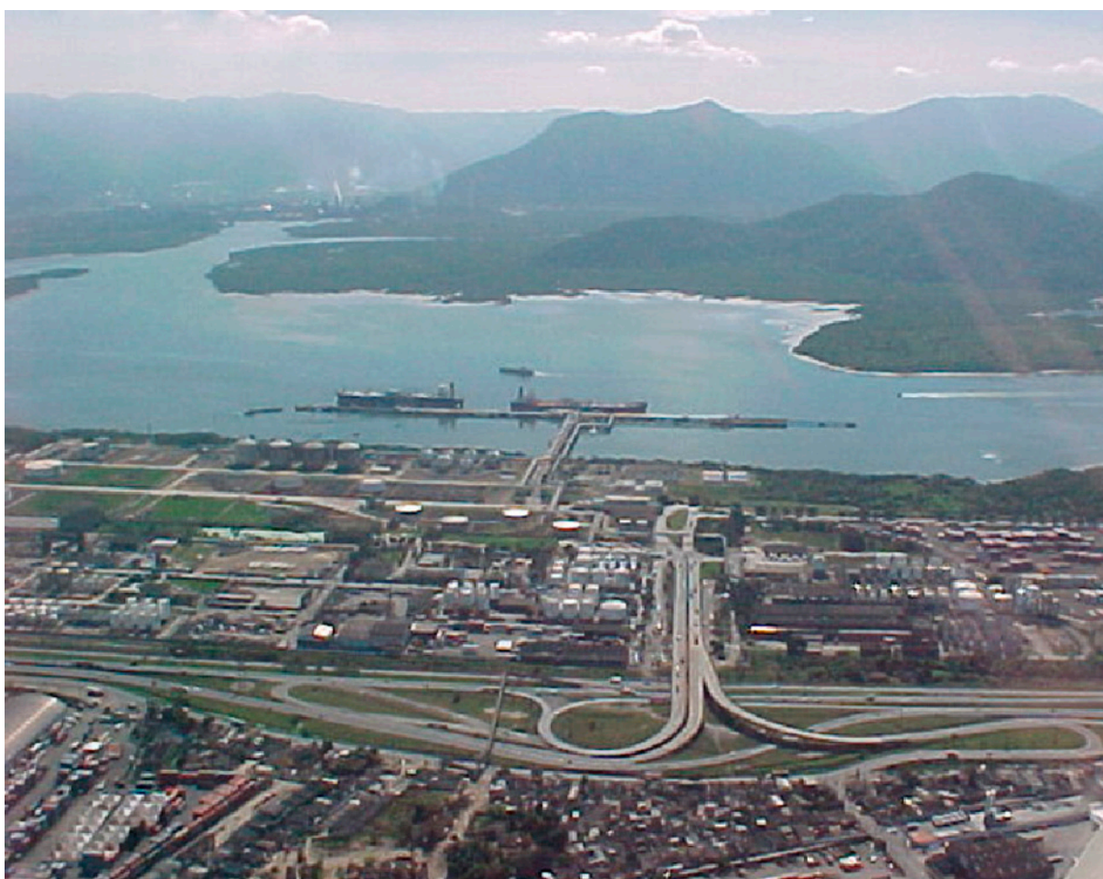
Foto 5.1 – Terminal de derivados de petróleo no Porto de Santos (Fonte: CETESB).
