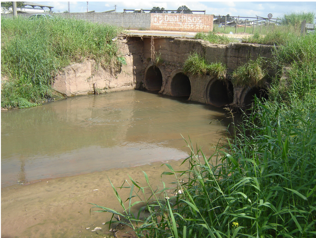
Figura 22: Ponto de amostragem da CETESB, localizado na Rua Tamotsu Iwasse, próximo à divisa entre os municípios de Arujá e Guarulhos, no bairro Bonsucesso, no município de Guarulhos. Coordenadas geográficas: 23°24'52,01"S 46°23'06,23" W. Datum WGS-84.
