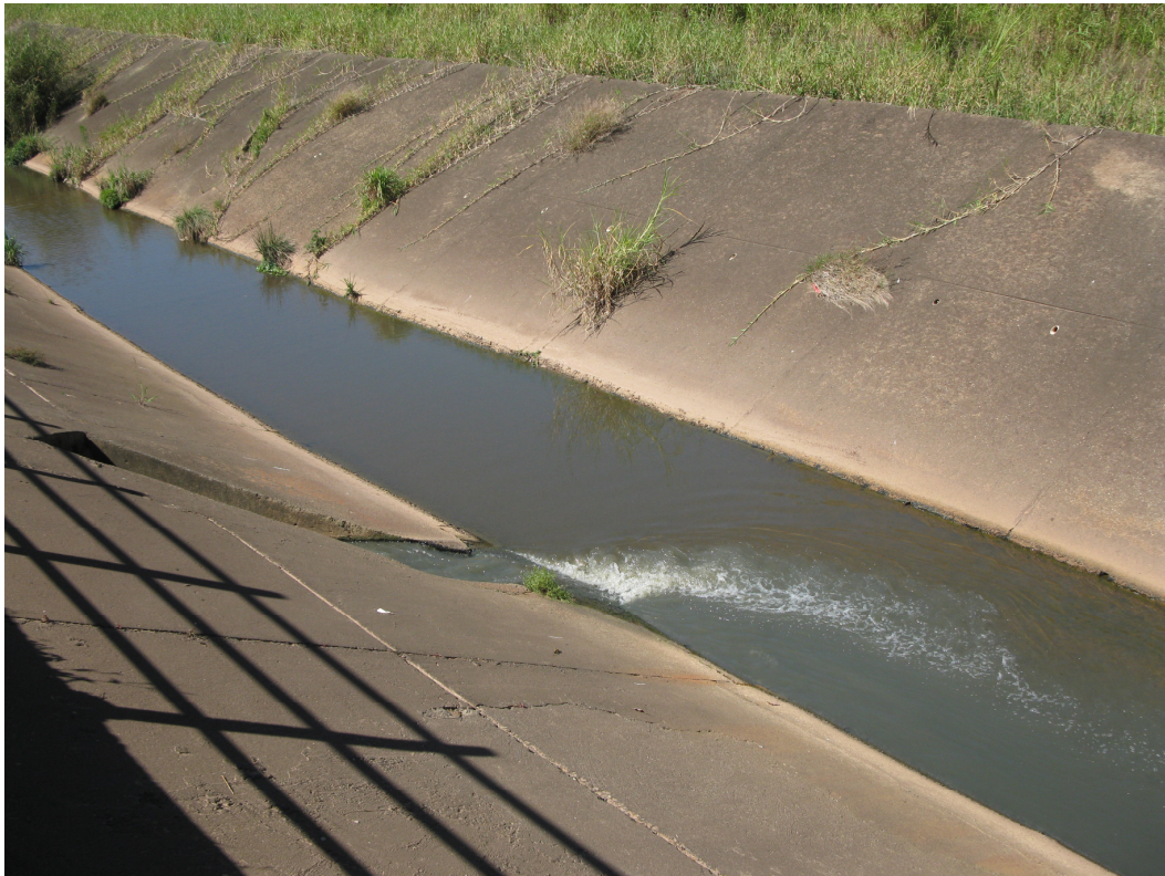
Figura 21: Trecho do Rio Baquirivu-Guaçu canalizado com seção aberta, no ponto de lançamento dos esgotos tratados da ETE, no bairro Portão, no município de Arujá. Coordenadas geográficas: 23°24'01,50"S 46°21'23,32" W. Datum WGS-84.
