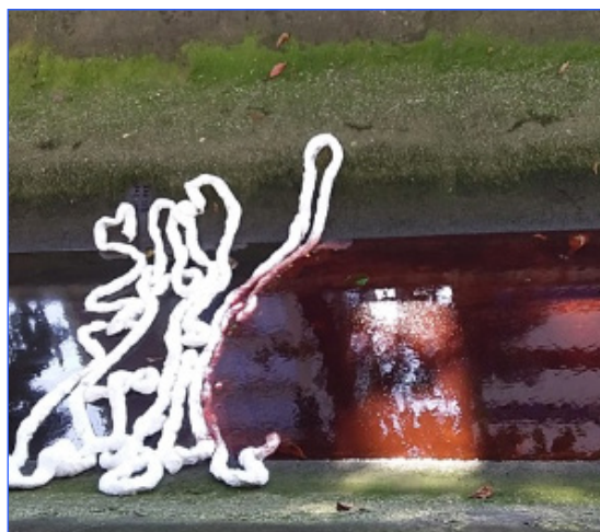
Aplicação de barreiras absorventes
