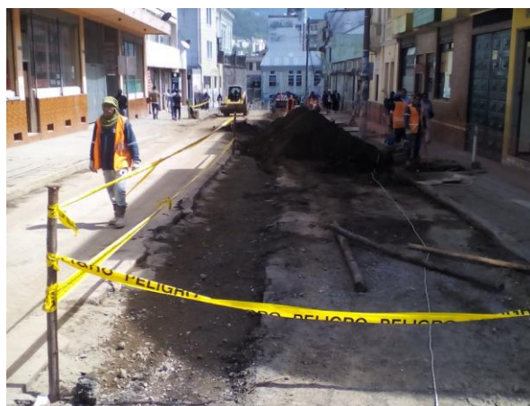
Figura 45: Intervenção em rede de esgoto em Quito (Equador), realizado pela companhia EPMAPS, em julho de 2017.
