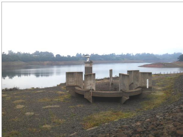
Figura 31: Vertedouro no reservatório Thika. Foto retirada pelo autor (jun/2017)
