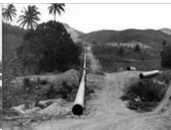
Figura 19: Implantação de adutora para abastecimento da cidade no início do séc. XX. Fonte: CAGECE, 2017
