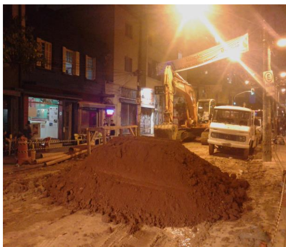
Figura 44: Intervenção noturna na rua Peixoto Gomide (São Paulo-SP) em setembro de 2015, para troca de tubulações de esgoto da SABESP. Foto retirada pelo autor.
