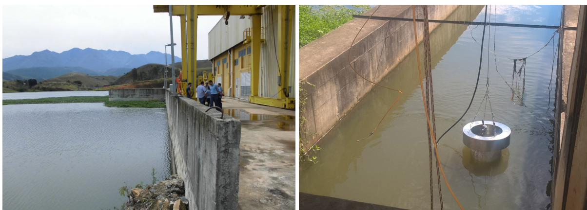
Figura 3.8 – EF26 – Queluz, PARB 02870 Vista da estação e do acesso a sonda, na margem do rio Paraíba
