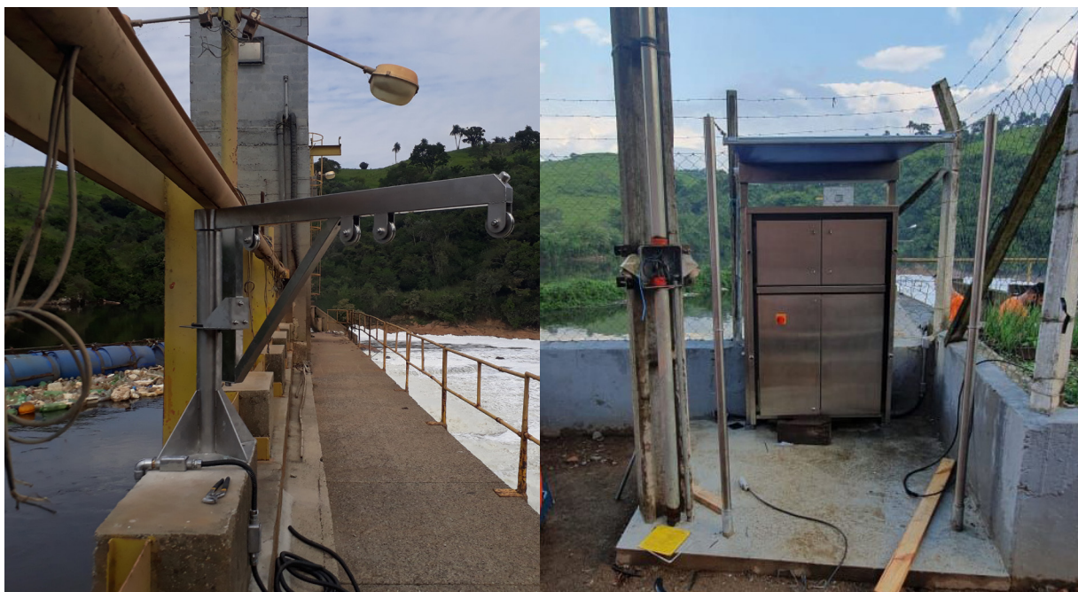
Figura 3.8 – Estação Automática TIET 02300 – EF28 – Itu (Fotos: Vinícius Silva).
