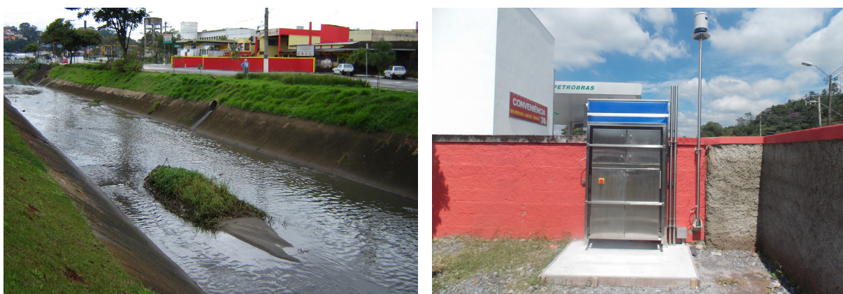
Figura 3.7 – PIRE 02800 - EF19 – Ribeirão Pires, na ponte da Av. Brasil, em frente ao corpo de Bombeiros, em Ribeirão Pires. (Fotos: Vinícius Silva).
