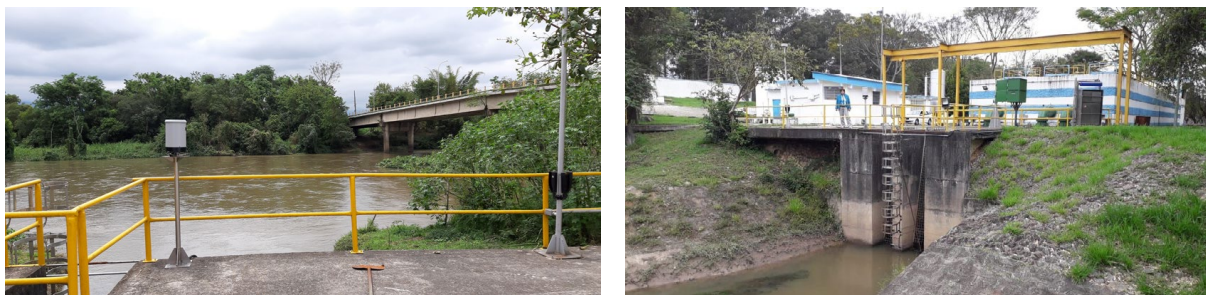
Figura 3.8 – Vista da nova estação EF 24 – Pindamonhangaba- PARB 02530 e do acesso a sua sonda, situada na margem direita do Rio Paraíba
