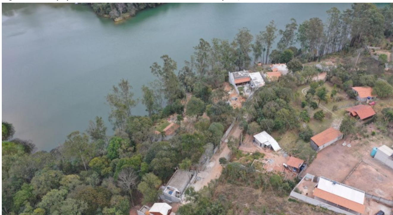
Figura 61 - Ocupação informal no bairro São Vicente em Mairiporã, SP
