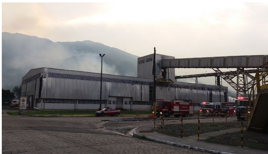
Figura 5.5 – Incêndio na Vale Fertilizantes em Cubatão
