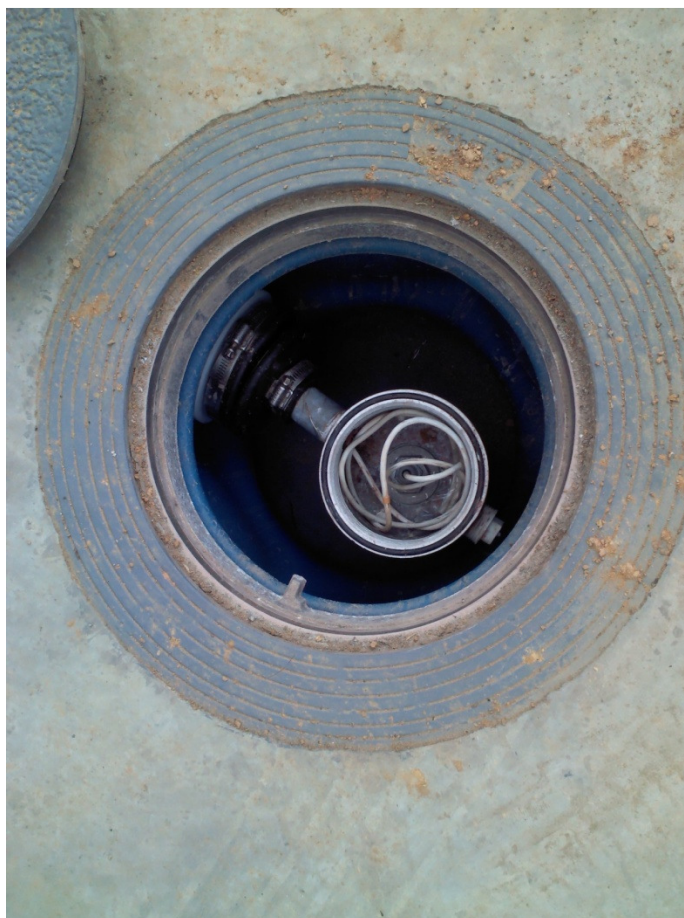
Figura 24 - Localização do sensor de monitoramento intersticial. Fonte: Autor (27/01/2014).
