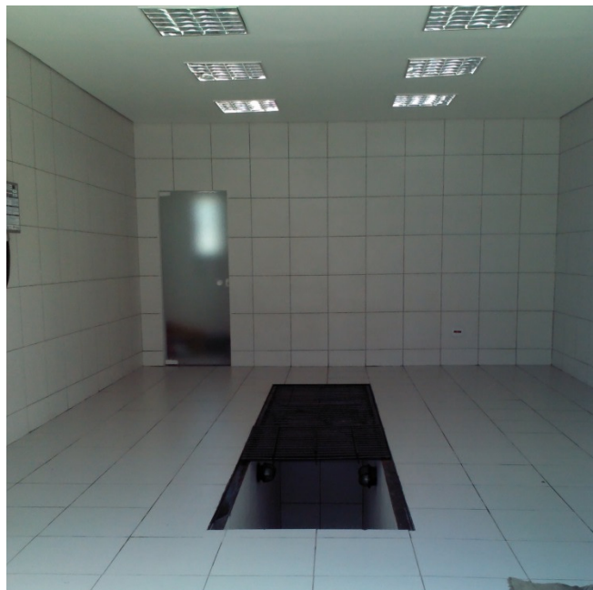
Figura 26 - Setor de troca de óleo. Fonte: Autor (27/01/2014).
