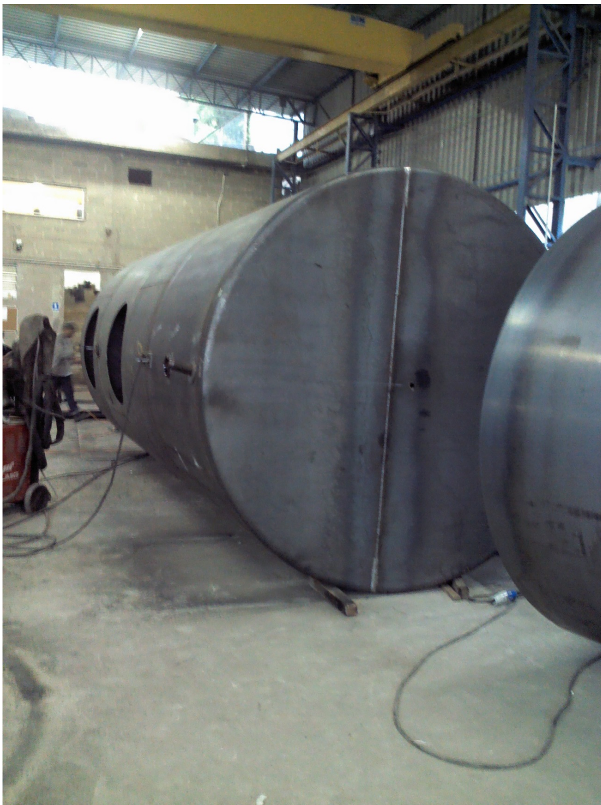
Figura 34 - Construção de tanque subterrâneo. Fonte: Autor (13/01/2014).
