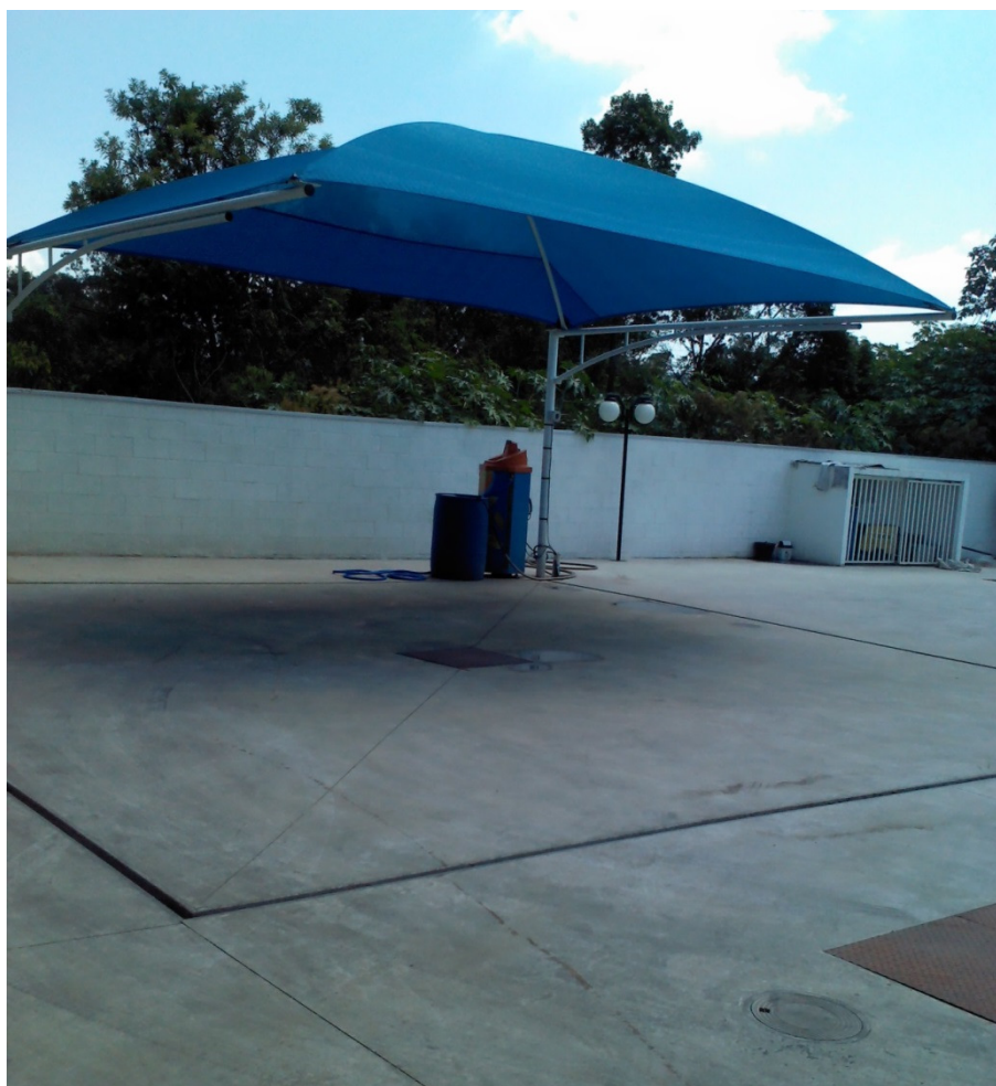
Figura 21 - Área de lavagem de veículos. Fonte: Autor (27/01/2014).
