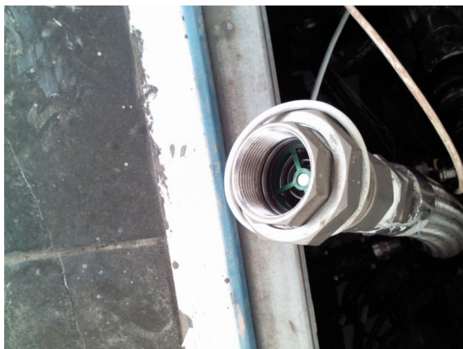
Figura 14 - Válvula de retenção check-valve . Fonte: Autor (19/04/2013).
