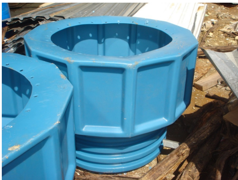
Figura 25 - Câmara de acesso a boca de visita. Fonte: Autor (12/03/2013).
