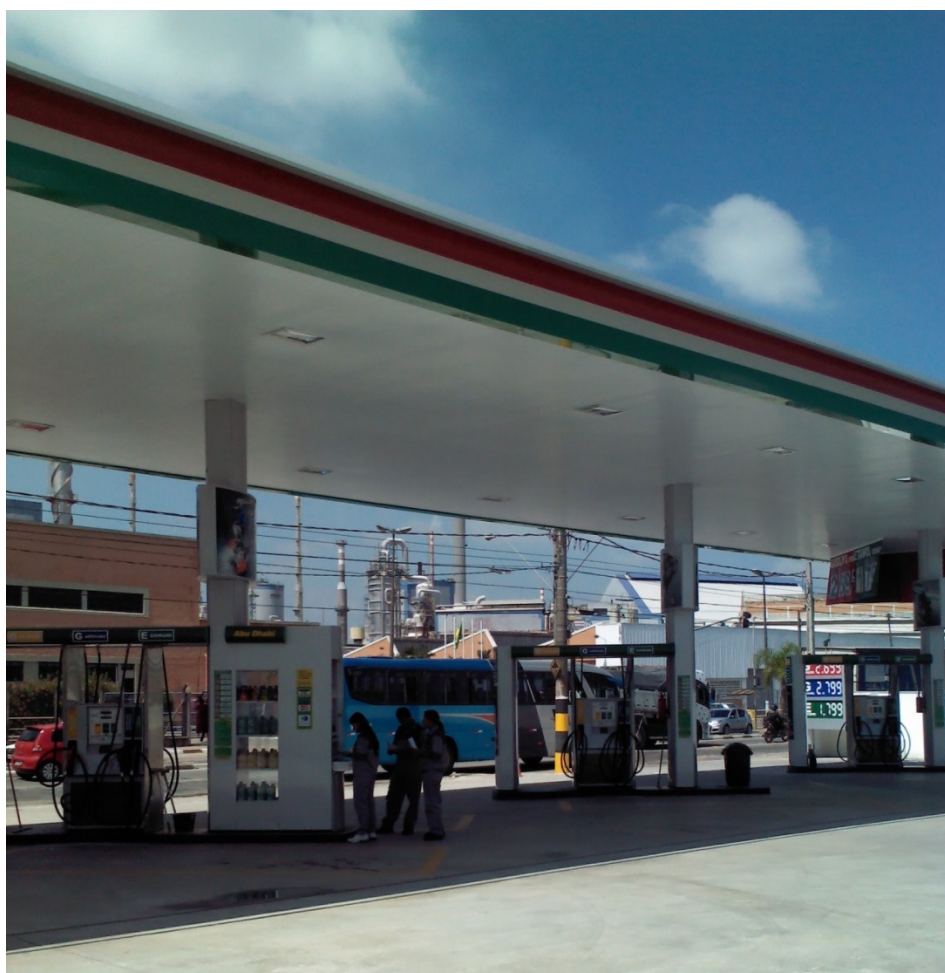
Figura 20 - Área de abastecimento dotada de cobertura. Fonte: Autor (27/01/2014).
