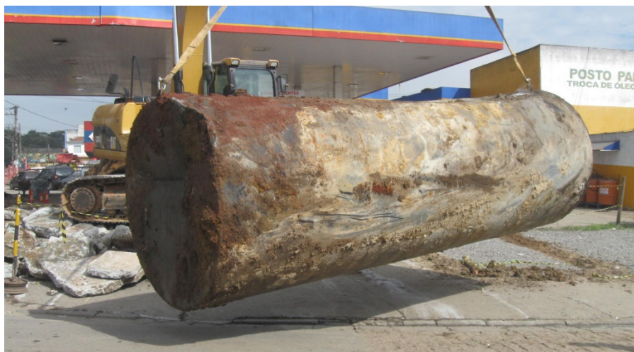
Figura 29 - Tanque subterrâneo em aço carbono sendo retirado para reforma completa do estabelecimento. Fonte: Autor (11/06/2013).
