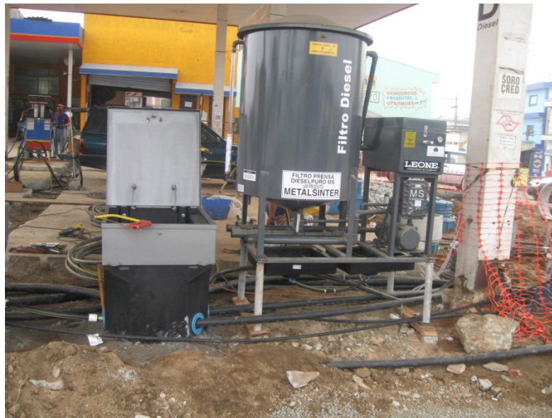
Figura 18 - Sistema de filtragem de diesel. Fonte: Autor (20/06/2013).
