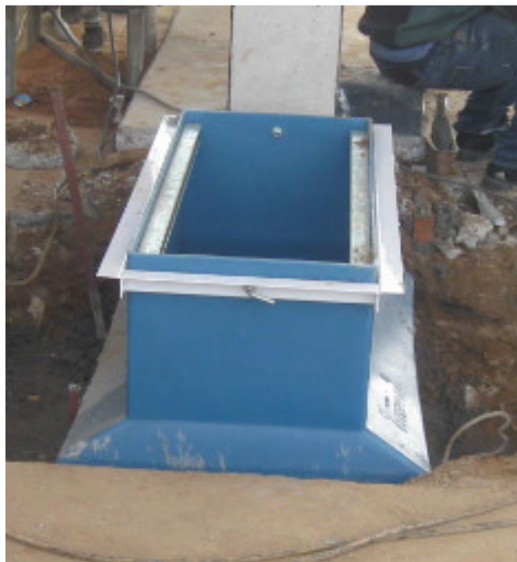
Figura 11 - Câmara de contenção da unidade de abastecimento. Fonte: Autor (19/06/2013)
