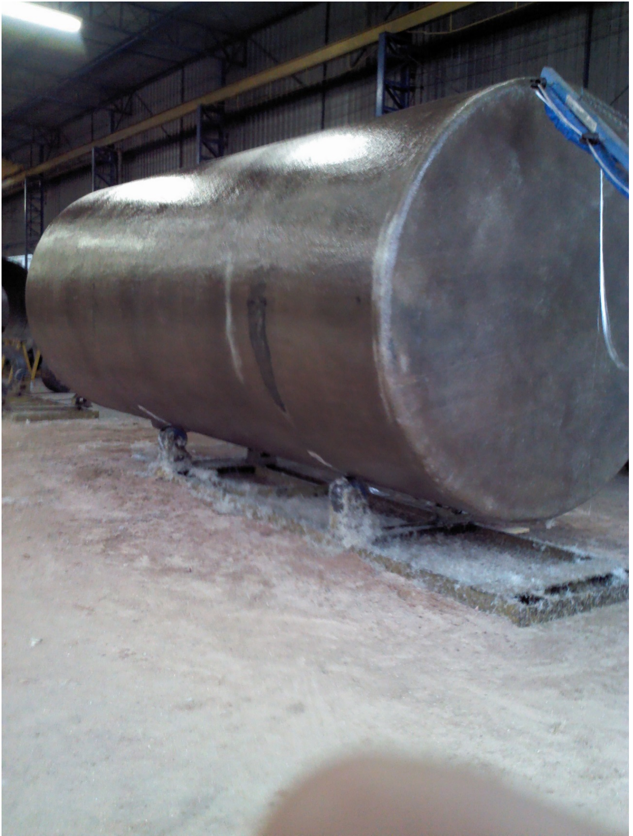
Figura 36 - Aplicação da camada de fibra de vidro. Fonte: Autor (13/01/2014).
