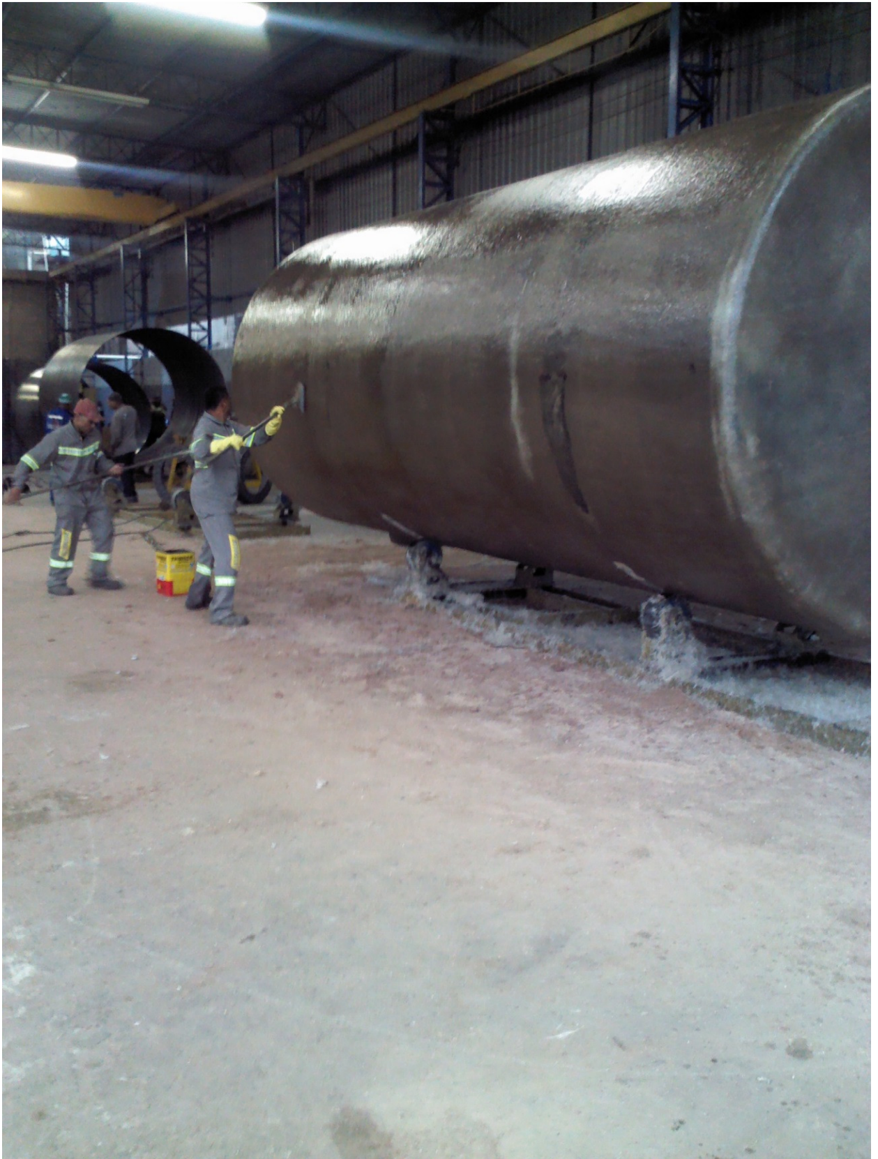
Figura 37 - Revestimento da camada de fibra de vidro. Fonte: Autor (13/01/2014).
