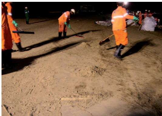
Foto 5.14 – Remoção manual de areia contaminada com óleo.
